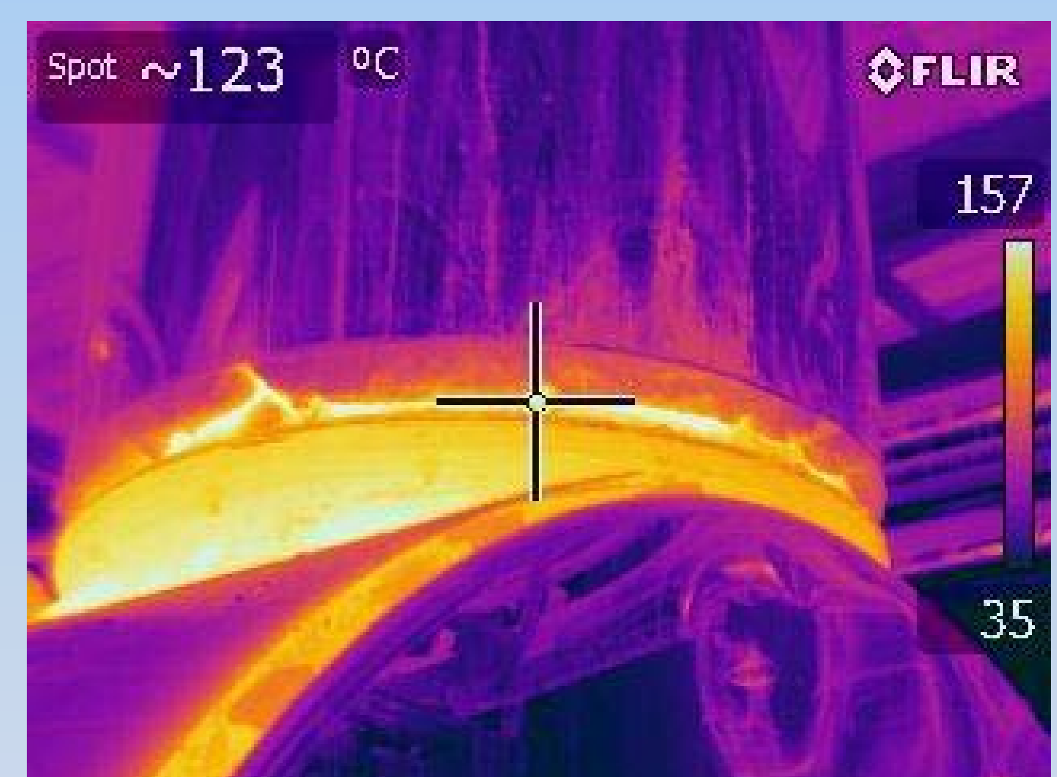
Pérdidas caldera calefacción
